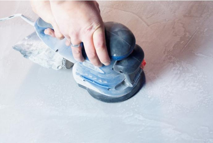
24 h après l'application de la 2eme couches, poncer avec une [ponceuse à main](#) la surface avec un disque de 80 puis 120.
