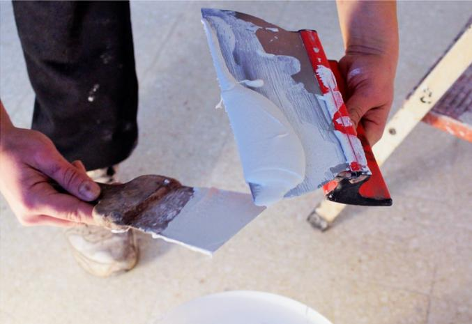
S'aider d'un couteau à enduire ou d'une truelle de stucateur pour doser le béton ciré sur sa lisseuse.
