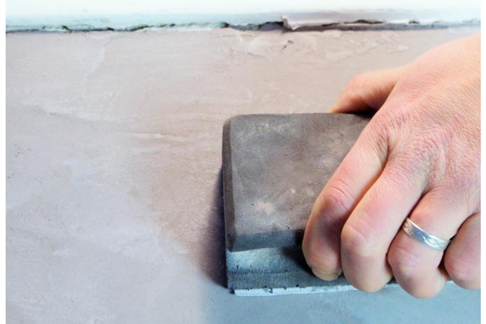
Pour faciliter le ponçage sur les bords ou dans les angles, utiliser [la cale à poncer](#).
