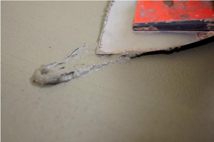
Revenir au fur et à mesure sur le béton ciré en déposant un peu de produit d'une façon aléatoire puis en le lissant pour l'incorporer dans la 2eme couches.
