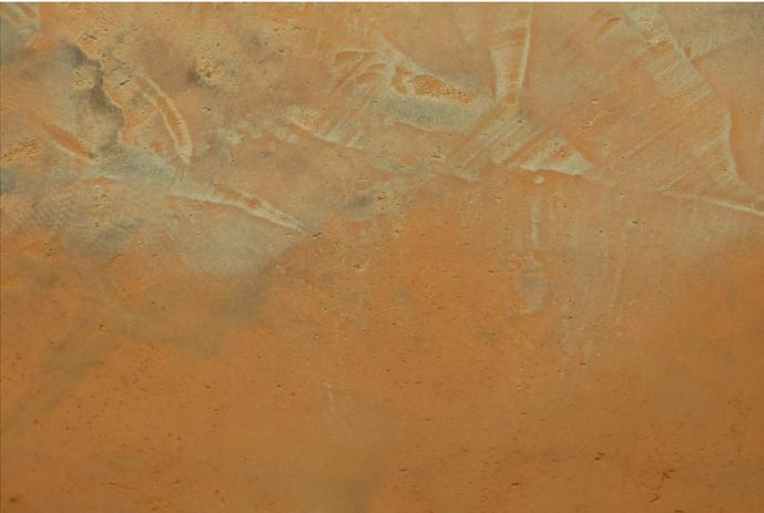
Le ponçage éclaircie le béton ciré et accentue les effets de ferrage.
