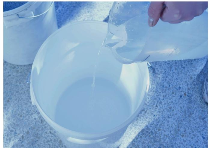
Verser dans un seau 1 à 1.2 litre d'eau. Dosage d'eau pour 4 kg de ciment colle.
