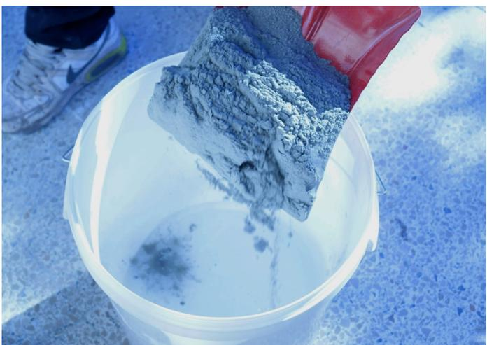
Rajouter 4 kg de ciment colle ou mortier de réparation.
