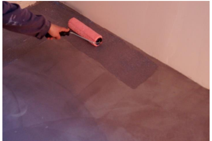
Après avoir dépoussiéré la surface, appliquer le bouche pores. Avec un rouleau de 500 mm . Laisser sécher 2 à 4 heures.
