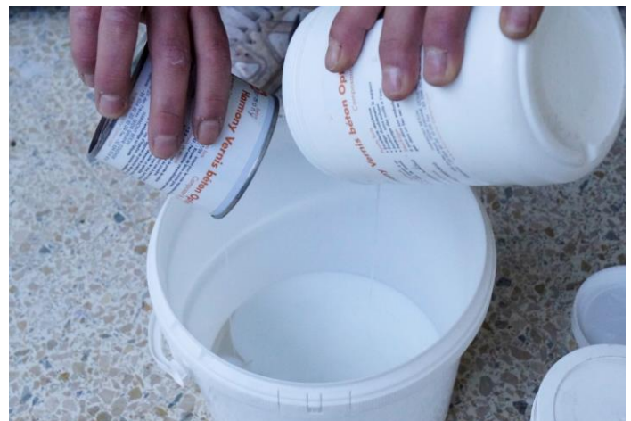
Verser les 2 composants du vernis Optimum ensemble dans un seau propre.
