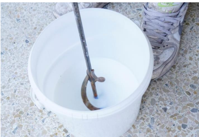
Mélanger les 2 composants avec à vitesse lente pendant 1 mn. Durée de vie du mélange +/- 45 mns selon la température ambiante.
