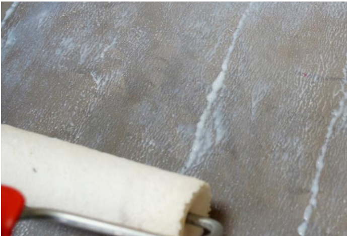
Appliquer le vernis en passe croisée uniforme.
