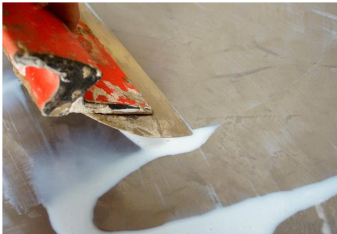
Appliquer le vernis optimum à l'aide de la parfaite lisse.
