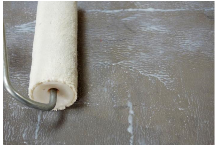
Laisser sécher au moins 6 heures et appliquer la 2eme couche.
