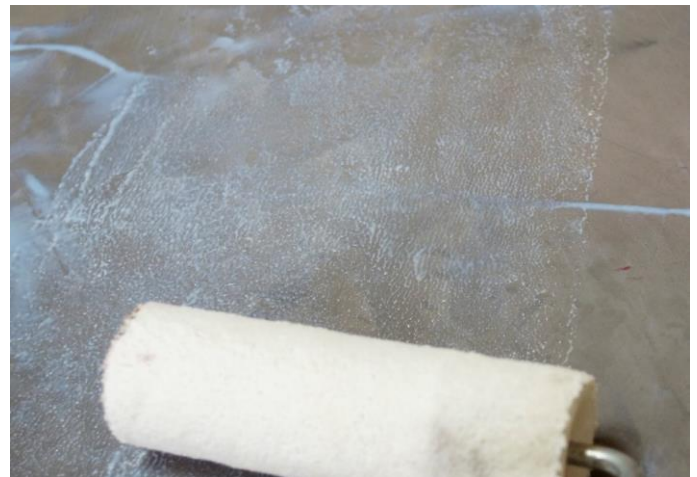
Lisser avec le rouleau spécial vernis afin d'uniformiser l'application. Laisser sécher au moins 6 heures et appliquer la 2eme couche.
