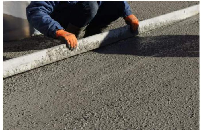
Utiliser une règle pour mettre la surface de niveau.
