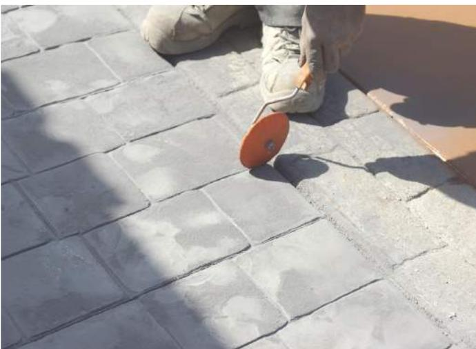
Pour finir de dessiner les joints en bordure, utiliser soit la roulette soit le S Tool.
