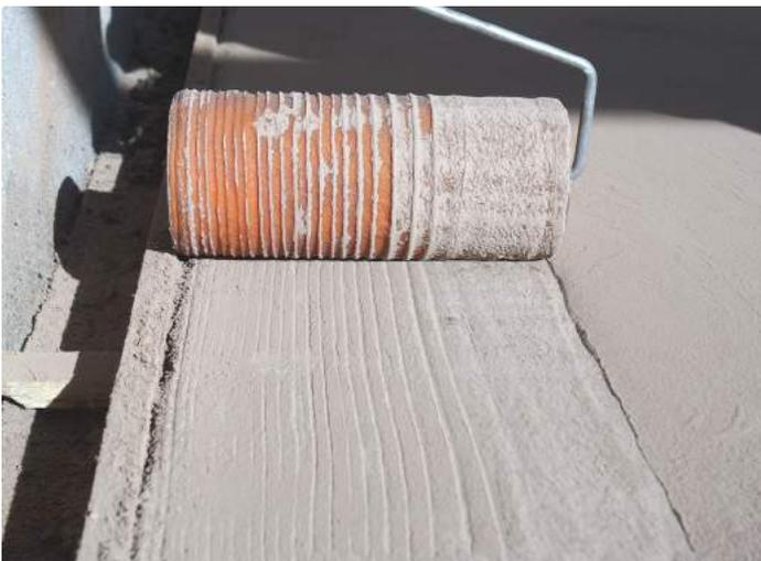
Astuce : Passer le rouleau texturé bois ou roche selon le type de moule pour bien imprimer les bords avant d'utiliser le moule souple.
