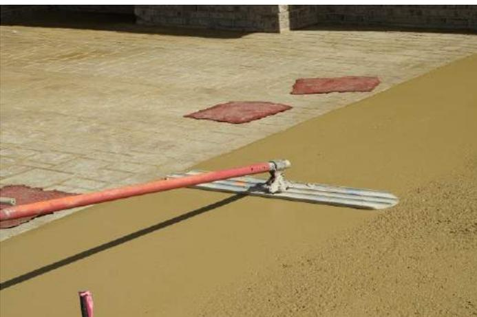
Utiliser la grande lisseuse magnésium à manche pour incorporer le durcisseur dans le béton et lisser la surface.
