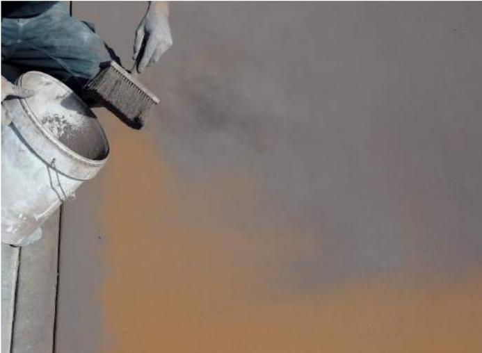
La surface est prête à être estampée lorsque celle-ci est devenue mate. C'est le moment de mettre en œuvre l'agent démoulant. Porter un masque et des gants. L'agent démoulant est très volatil.
