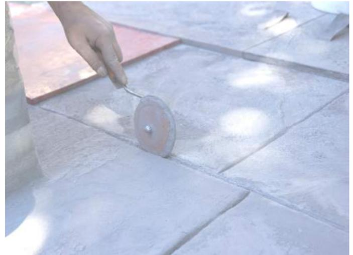
La roulette de finition permet au fur et à mesure d'enlever les bavures entre 2 moules
