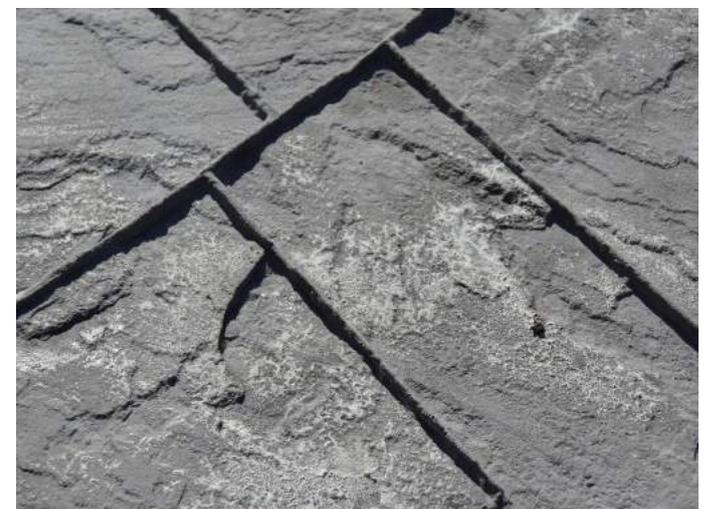
Si votre moule fait apparaître des traces de laitance en surface après avoir imprimé, il faut les essuyer. Attention, cela est dû à un béton encore trop frais et/ou au fait de damer trop fort.
