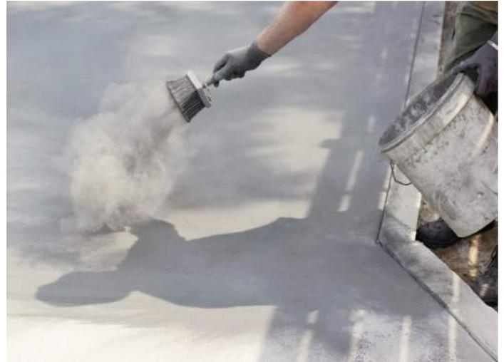
Utiliser la brosse à démoulant et répartir uniformément l'agent démoulant au fur et à mesure de l'avancement et poser la matrice.
