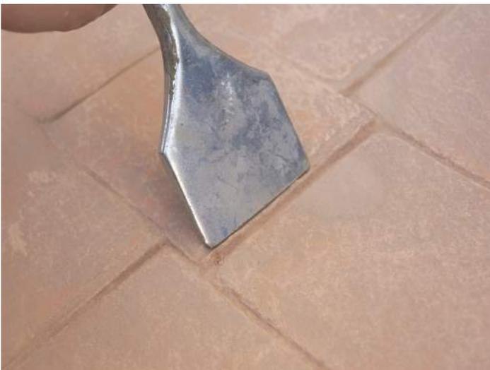
Dans le cas où entre 2 moules, le béton a créé une lèvre, utiliser un burin large.
