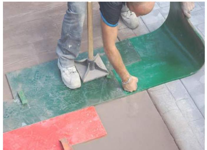
Pour les bords ou contre les murs, utiliser un moule souple.
