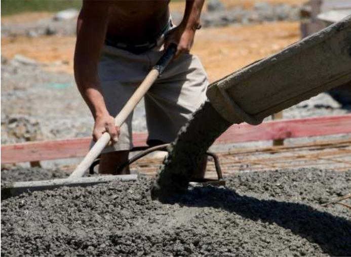
Après avoir réalisé son coffrage et mis en place le treillis sur un polyane, couler le béton. Le béton devra être d'une consistance Abrams S3 .
