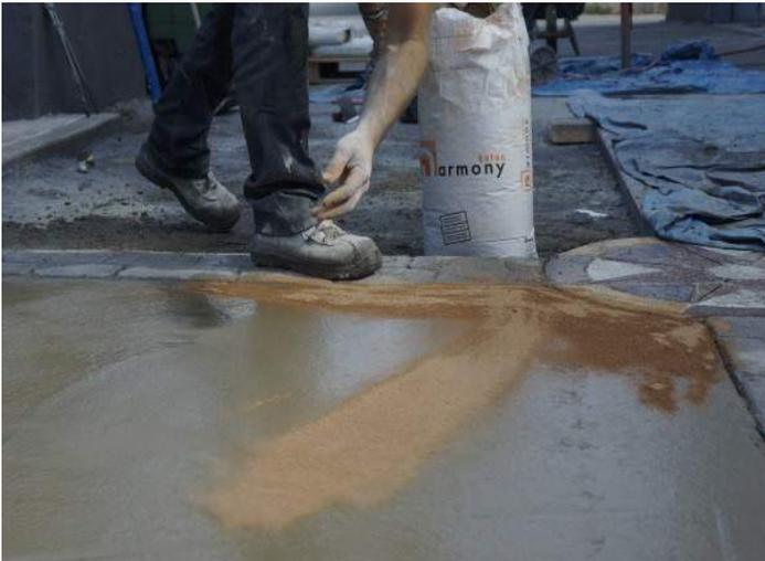
Jeter le durcisseur sur toute la surface du béton afin de recouvrir totalement le béton y compris sur les bords.
