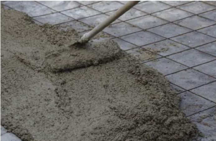
Répartir le béton avec un épandeur à béton.
