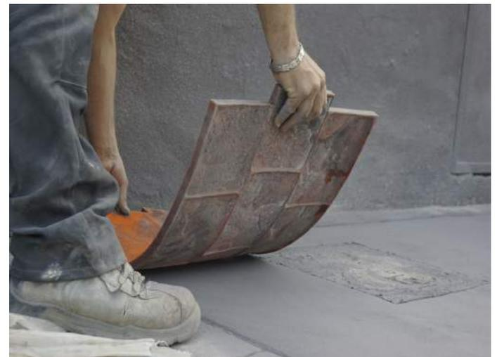
Commencer à poser les moules pour imprimer le béton.
