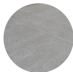
Chape en béton
