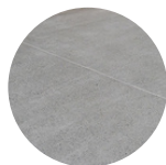
Chape en béton
