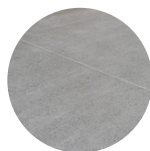
Chape en béton
