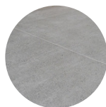
Chape en béton
