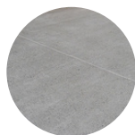
Chape en béton
